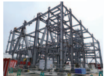
建設中の北海道の紋別バイオマス発電所。 燃料には主に林地未利用材を活用する。
